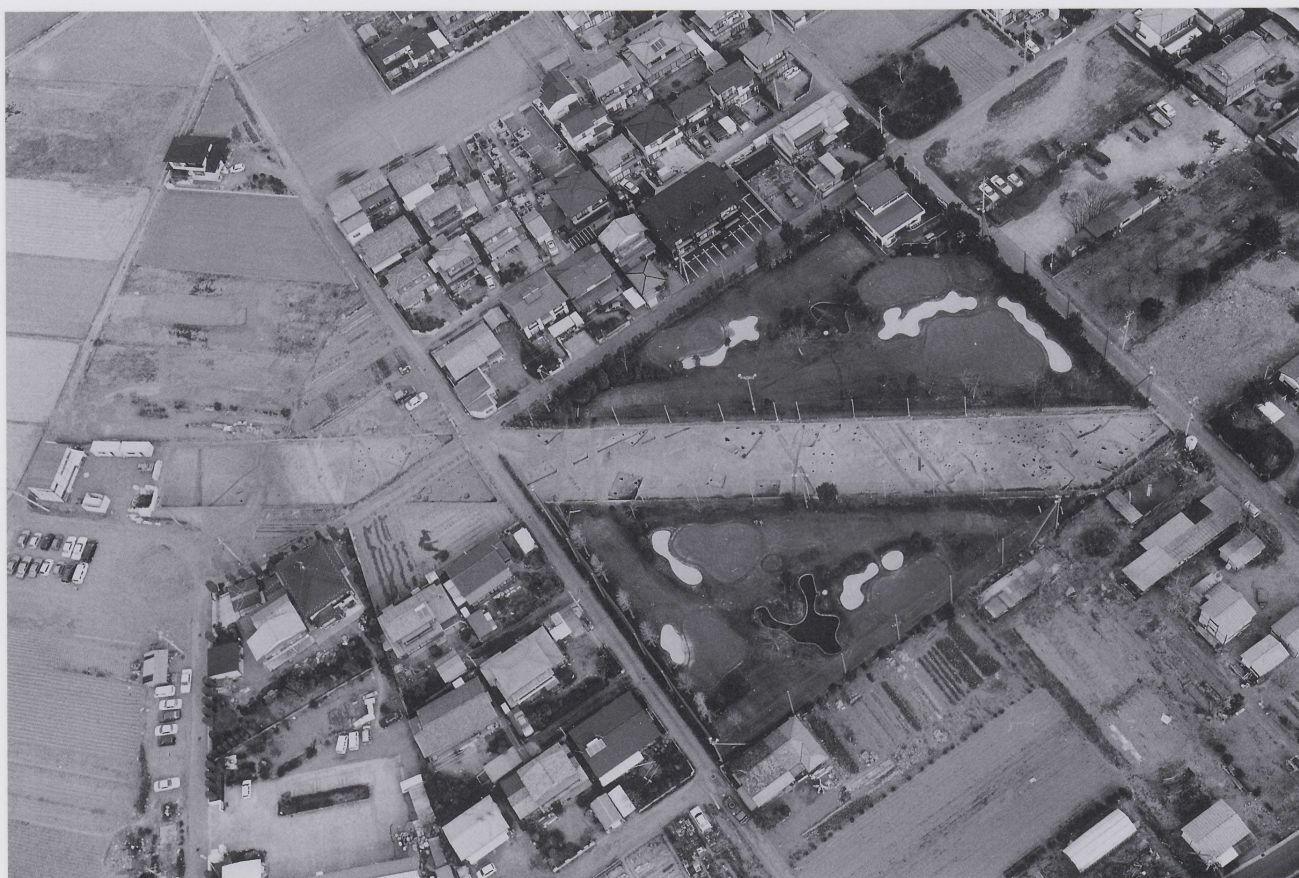
2 夏目西・弥藤次遺跡全景（南から）
