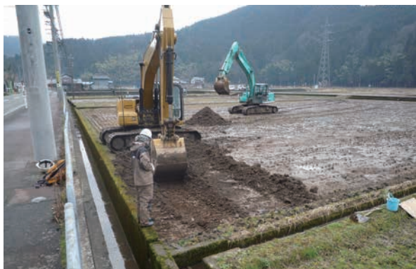
東区北半表土掘削(北より)
