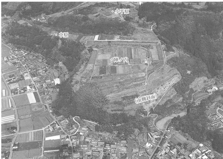
陣ノ内館跡航空写真（南→北） 南側・南東側の斜面に小段が連なっている
