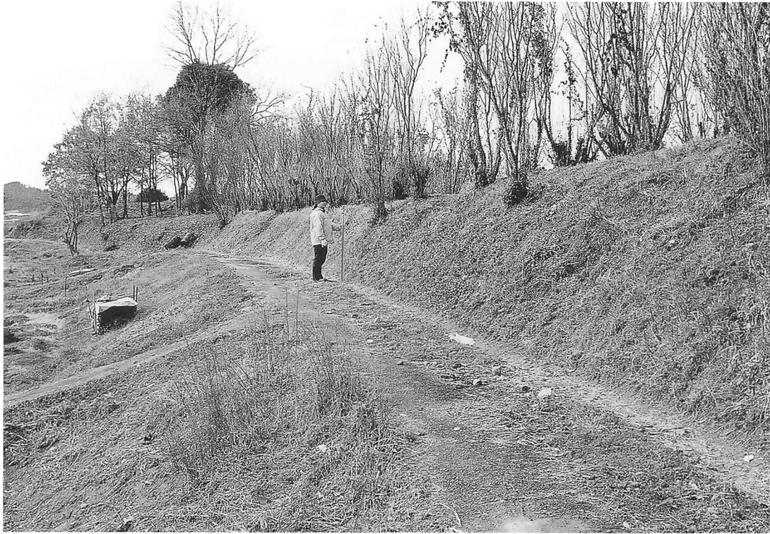
図版 14 大土壘「上げ土」 B 4 下の農道から B 2・B 1 を見る
