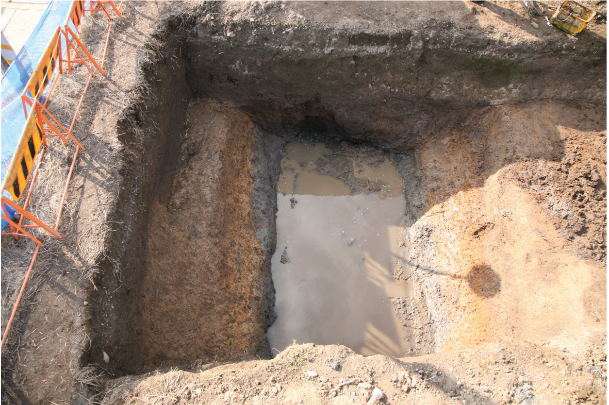
1 第2号堀完掘（東より）
