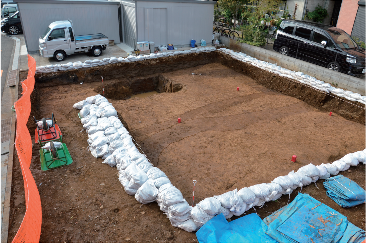
1 遺構検出状況（1）（南東から）
