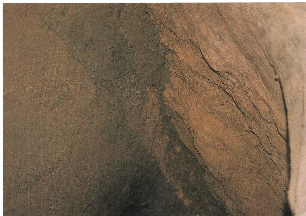
6. II区 SK203 土層断面（崩落土） 東から
