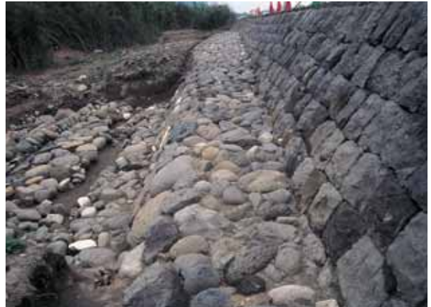
II区 石積前鞘巻き 東から
