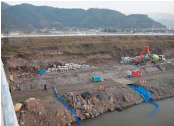
安津橋根元(右岸) 災害復旧工事箇所
