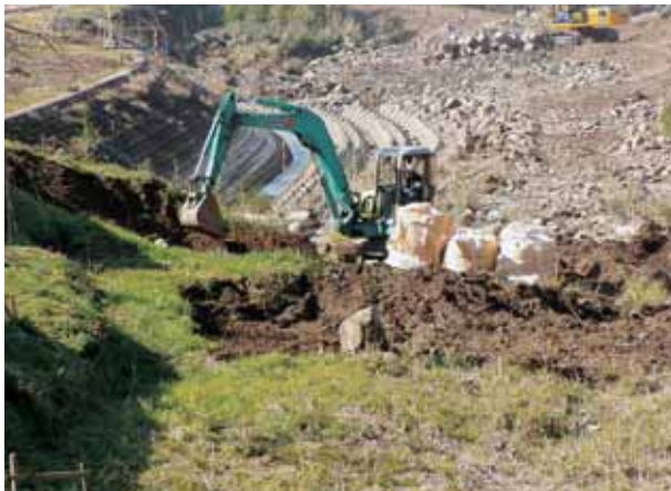
調査状況 表土剥ぎ
