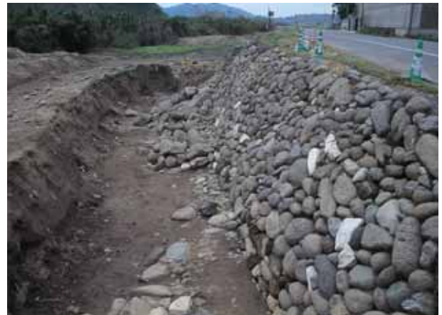
Ⅳ区 東側石積前 旧堤防残存状況 東から
