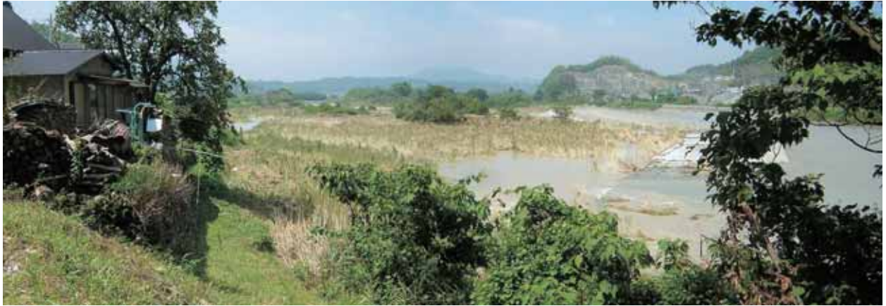
鵜ノ瀬堰調査前全景 南東から
