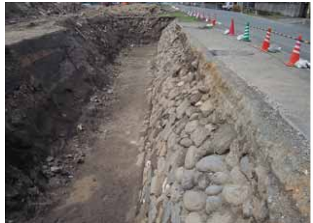
VII区 石積出土状況 東から
