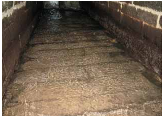
築の樋門 石畳部分
