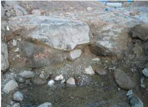
石敷基礎確認トレンチ 土層断面 (A-A')
