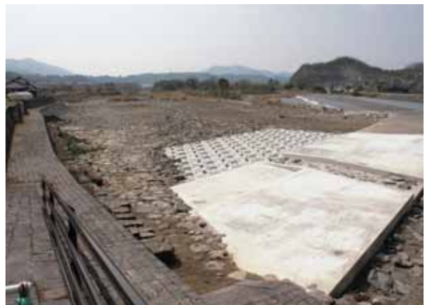
平成24年 現在の鶺ノ瀬堰 流された石畳部分はコンクリートで修復された
