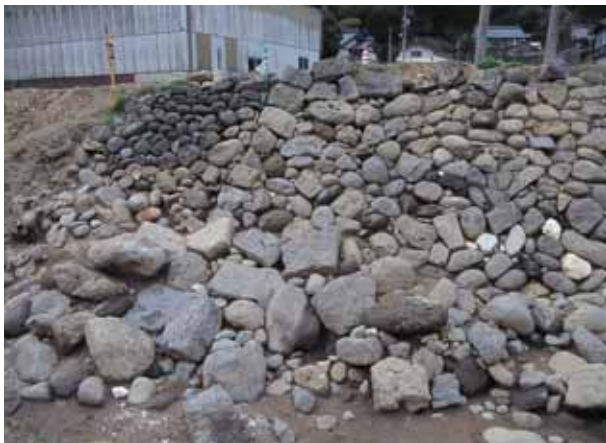
Ⅳ区 勿拡張部分 南から
