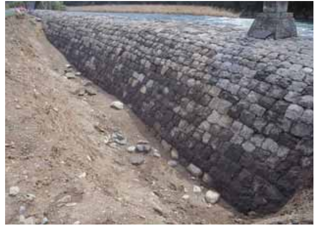
Ⅷ区 芻裏側出土状況 北西から
