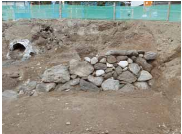
石積正面 南から
