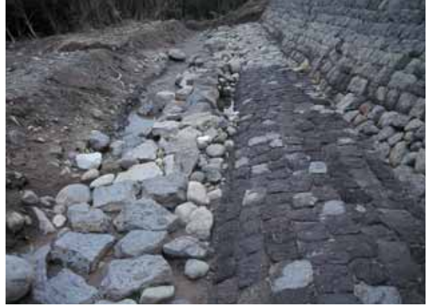
I区 東側石積基礎出土状況 東から
