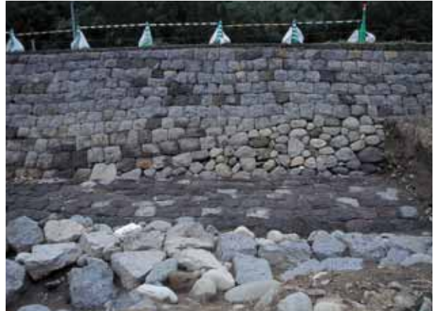
I区 東側石積立面 南から
