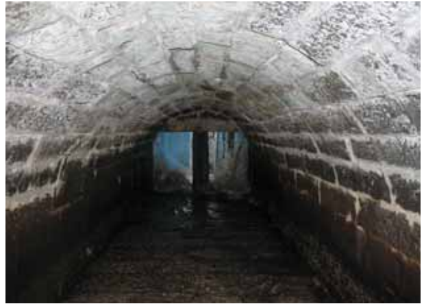
築の樋門 天井部分
