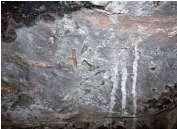
築の樋門 天井部分 “六”が刻まれる
