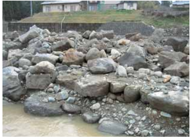
平成19年7月の被災により剥がれた石敷(左岸)②
