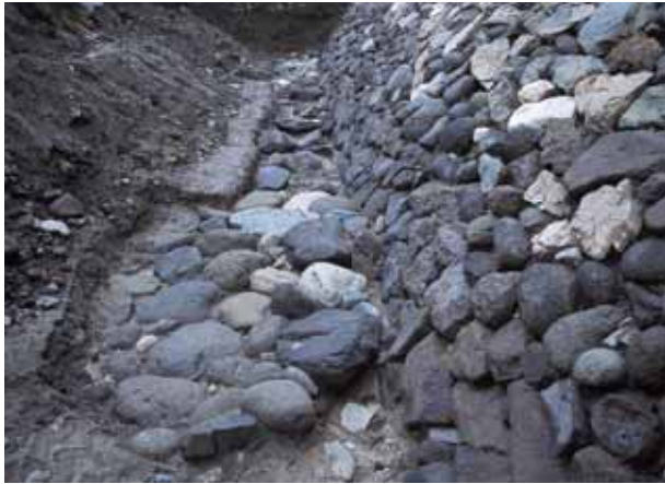
Ⅸ区 東側石積前基礎固め状況 東から
