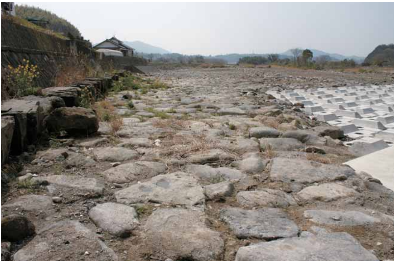
現在の鶴ノ瀬堰の石畳(左岸：東寒野側) 東から
