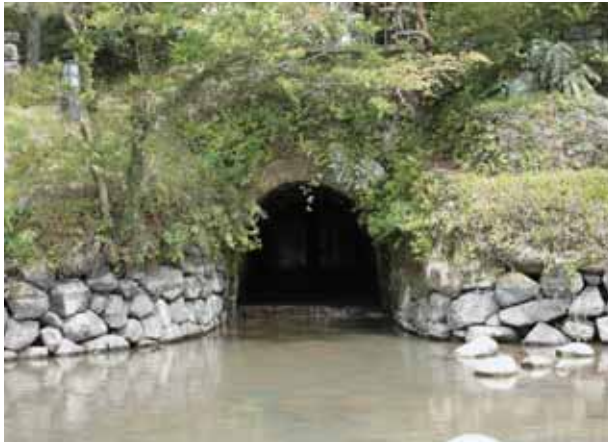
鵜ノ瀬堰下流 築の樋門 西から
