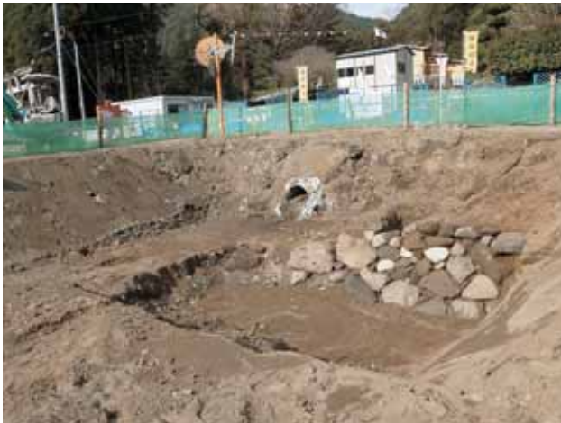
樋管工事部分出土状況 南東から
