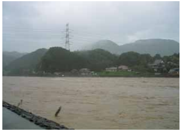
平成19年7月 被災中の鶺ノ瀬堰 右岸から 洪水が鶺ノ瀬堰を襲う 堰体の場所が白く波立つ
