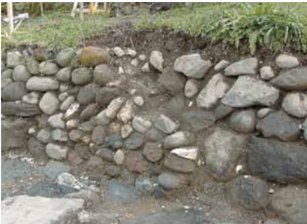
石積出土状況③ 旧石積の前に現石積が作られる 北西から
