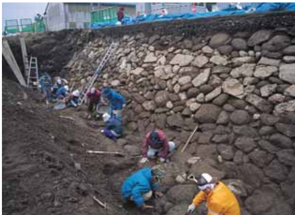
石積検出作業状況
