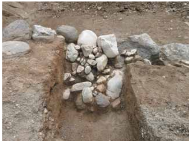
石積裏込め状況 北から
