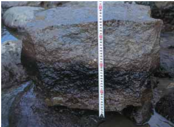
往還眼鏡橋 アーチ下基礎石 流水による変色
