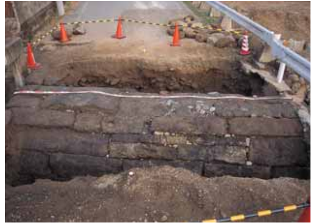
往還眼鏡橋 掘削状況 西から
