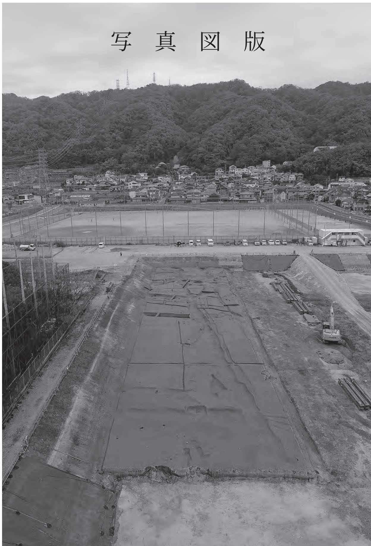
2区調査地遠景（西から）
