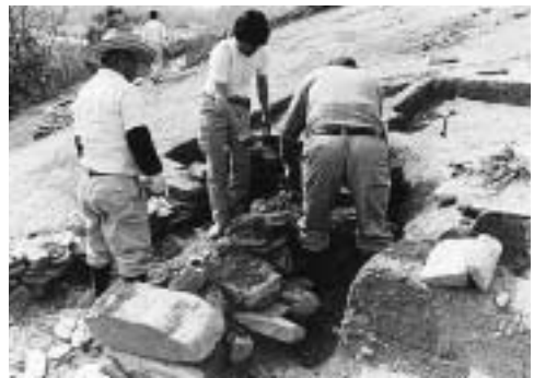
5. 2号墳石室解体作業風景
