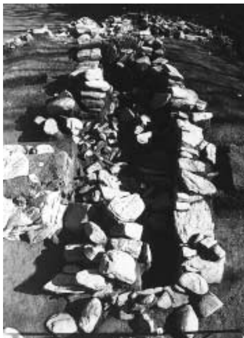
1. 1号墳石室崩壊状態（北西より） 東側壁の崩壊が顕著。 一方向から重力が石室を崩壊へ至らしめた事がわかる。
