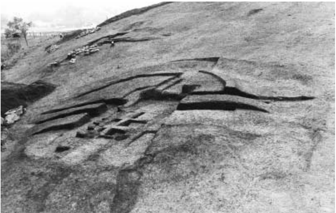
5. 解体後の1・2号墳 (東より)
