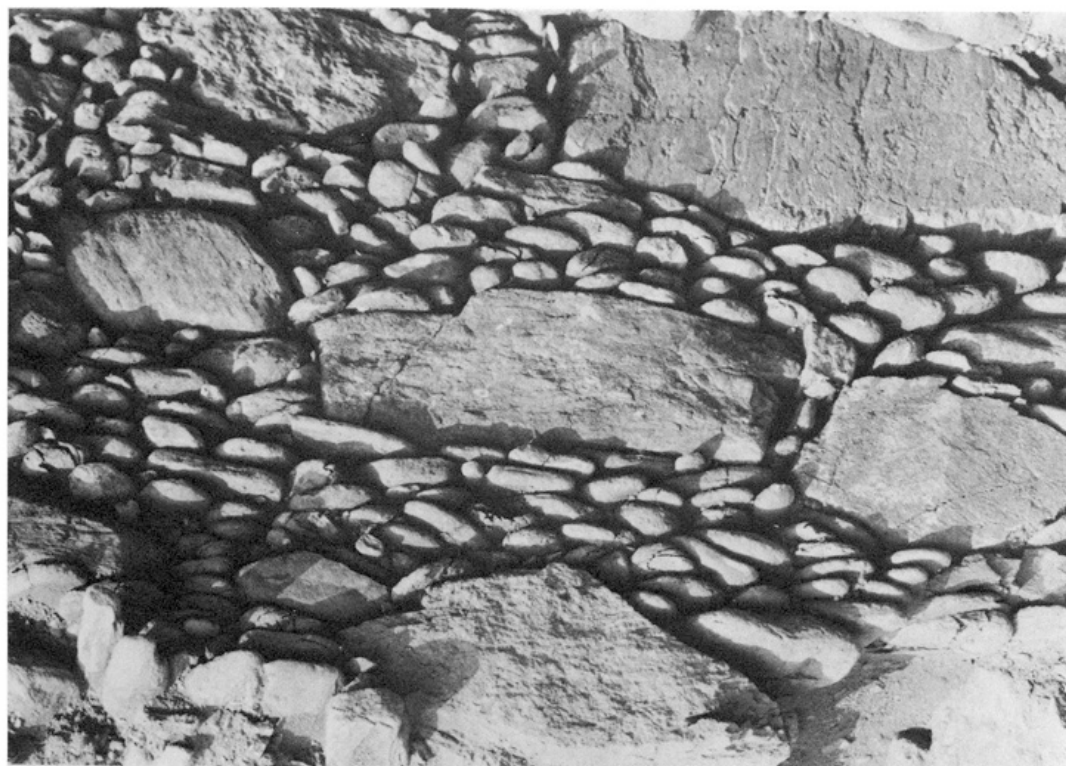
2. 長沖21号墳側壁積み方近景
