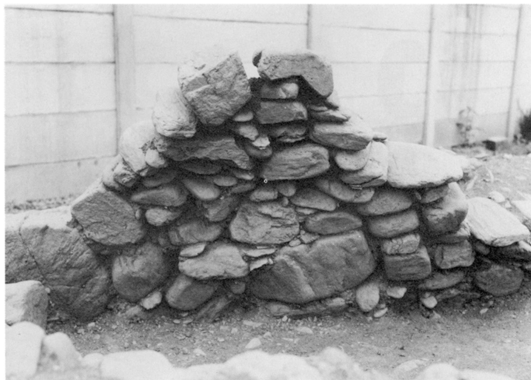
2. 長沖28号墳石室側壁積み方近景
