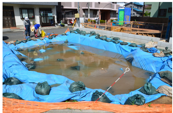
8 2区冠水状況 (南西から)
