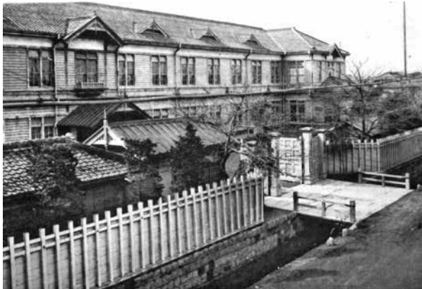
明治45年頃(敷地北辺にある表門。敷地境に溝がある。)
