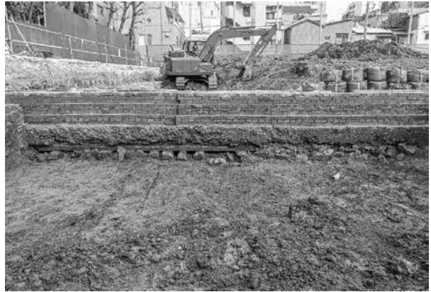
6. 35号遺構東辺内部側面(西から)
