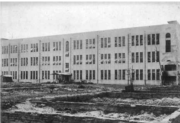
大正12年頃(関東大震災直後。講堂は焼失。奥は焼け残った西側コンクリート校舎か。)
