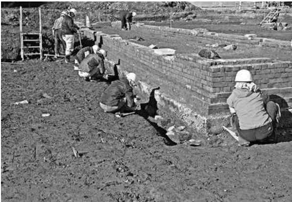
7. 35号遺構調査作業
