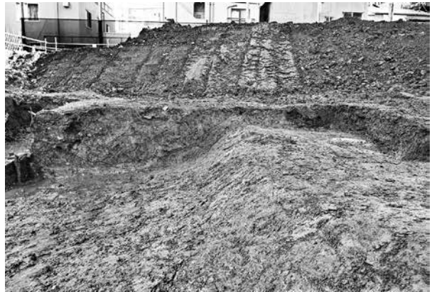
4. 33号遺構裏込め土層堆積状況（Ⅰ区東）（西から）
