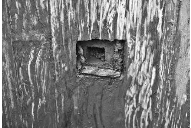
4. 95号遺構木樋接続部分近影（東から）
