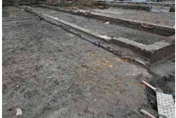
写真5 35号遺構に沿う土管列 (37号遺構)
