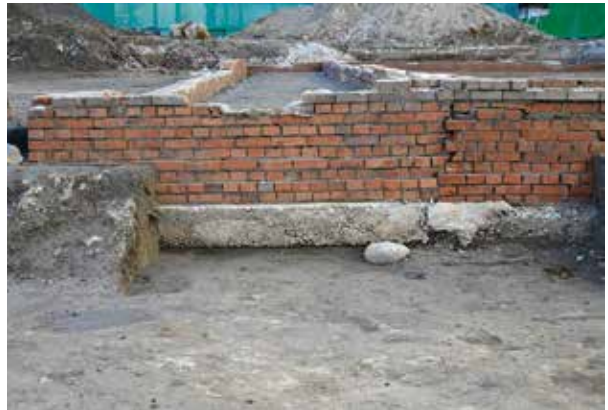
写真3 35号遺構の東側側面
