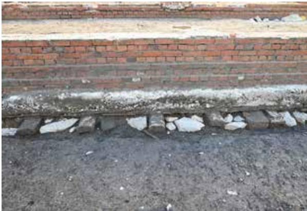
写真2 35号遺構の南側側面
