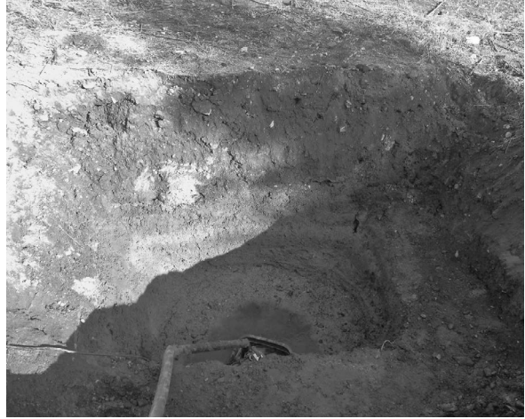
fig.184 2 トレンチ全景 (南から)
