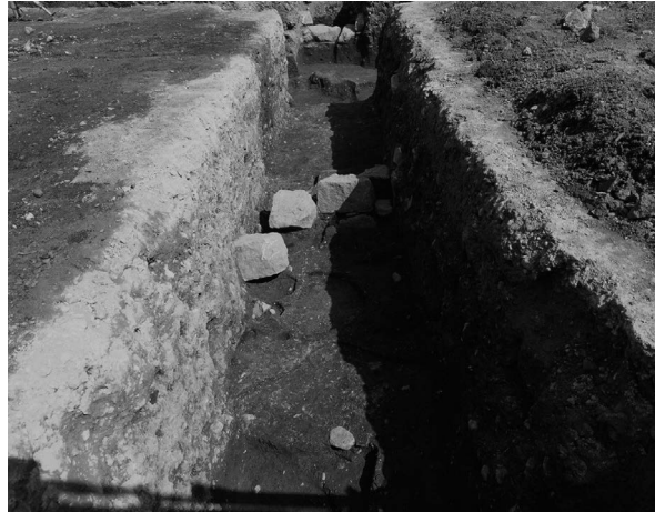
fig.108 D区第2遺構面検出状況（西から）
