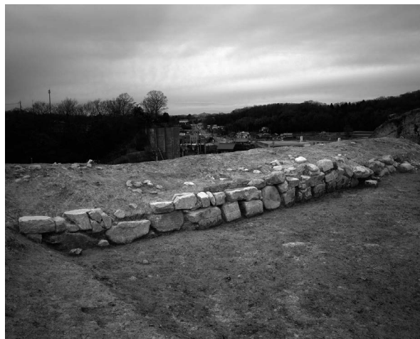
fig.194 曲輪2北西下層土塁南半（南から） 曲輪内部側のみ石積が存在
