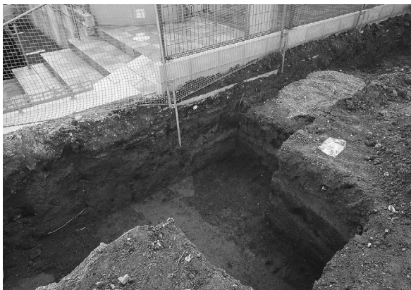
fig.34 A区第1遺構面検出状況（北から）
