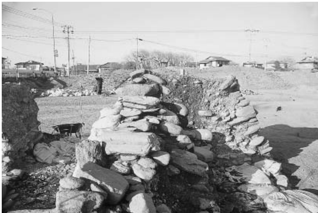
東側壁裏側の状況 1 (南から)
