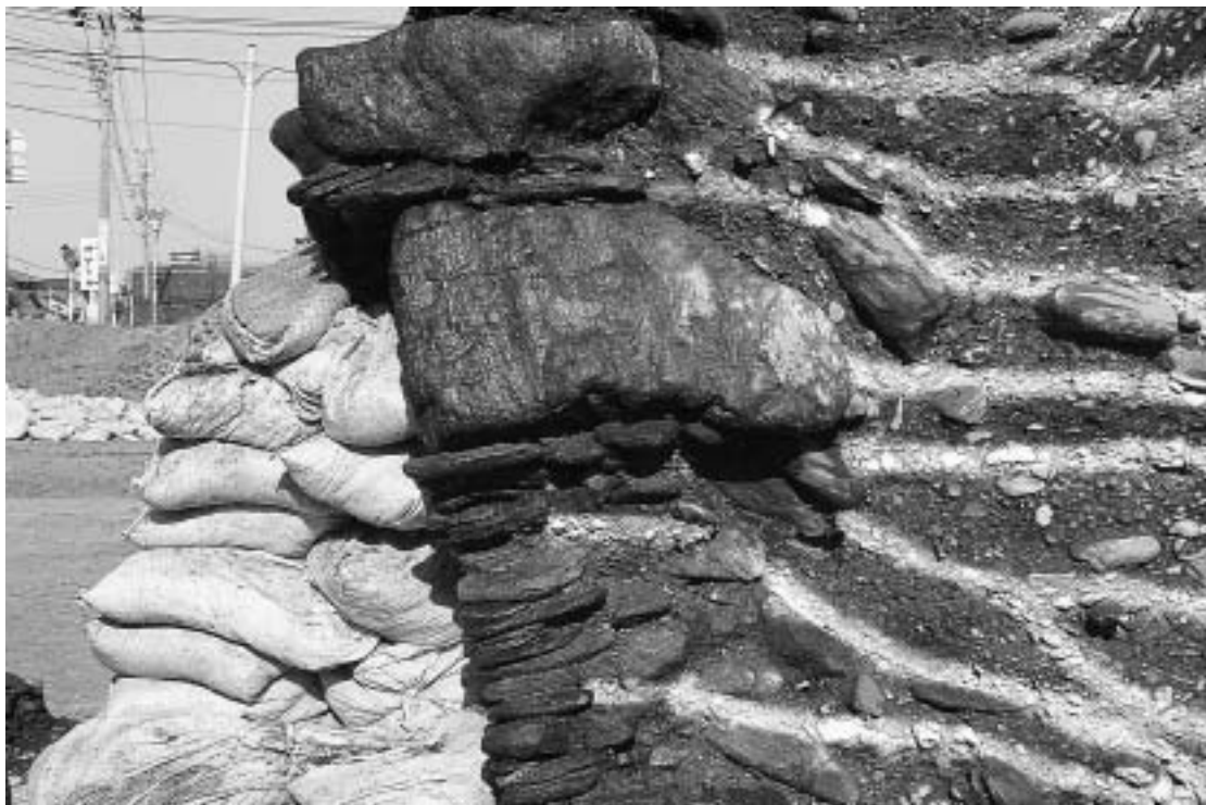
控積断ち割り状況 3 (東側・部分)
