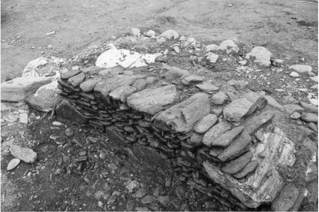
東側壁裏側の状況 3 (南西から)
