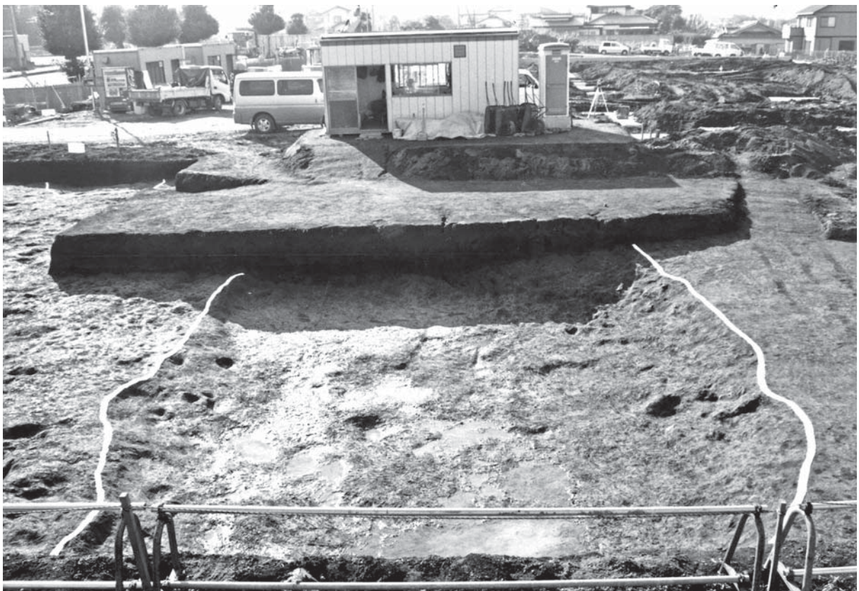
第192号墳周溝跡（東より）
