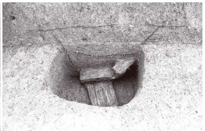
(5)SB 4 [SP62] 礎板(西より)
