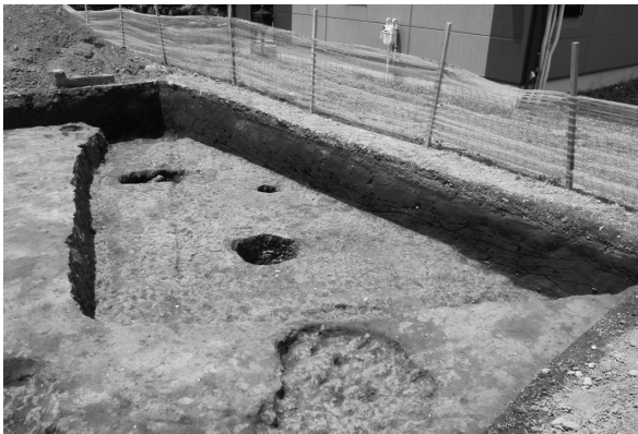
SI-1 完掘状況 北東から
