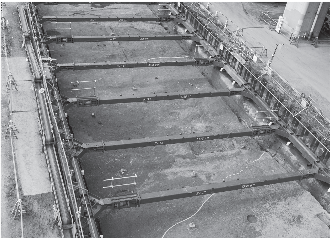
2. 3区 240 流路（北東から）
