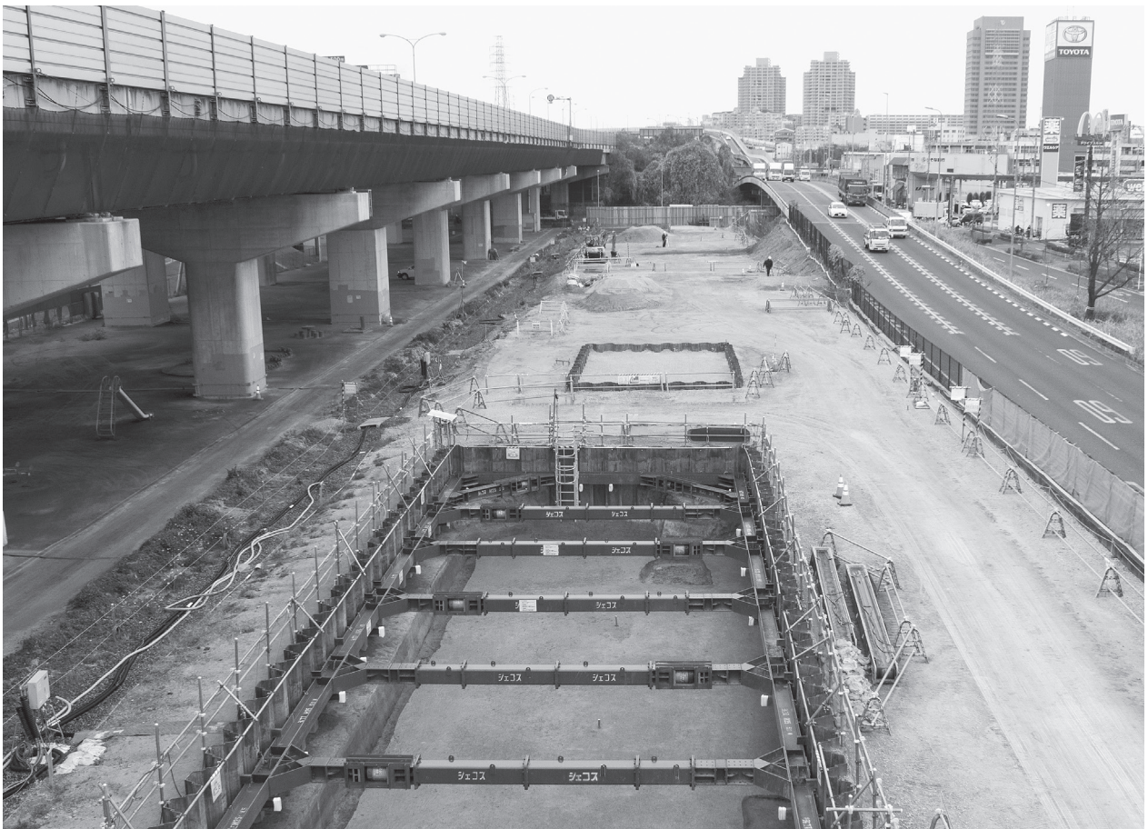
2. 調査区遠景（2区南から1・2区をのぞむ）[右が主要地方道大阪中央環状線で、支柱を建て、この上に大阪モノレール軌道を建設予定]
