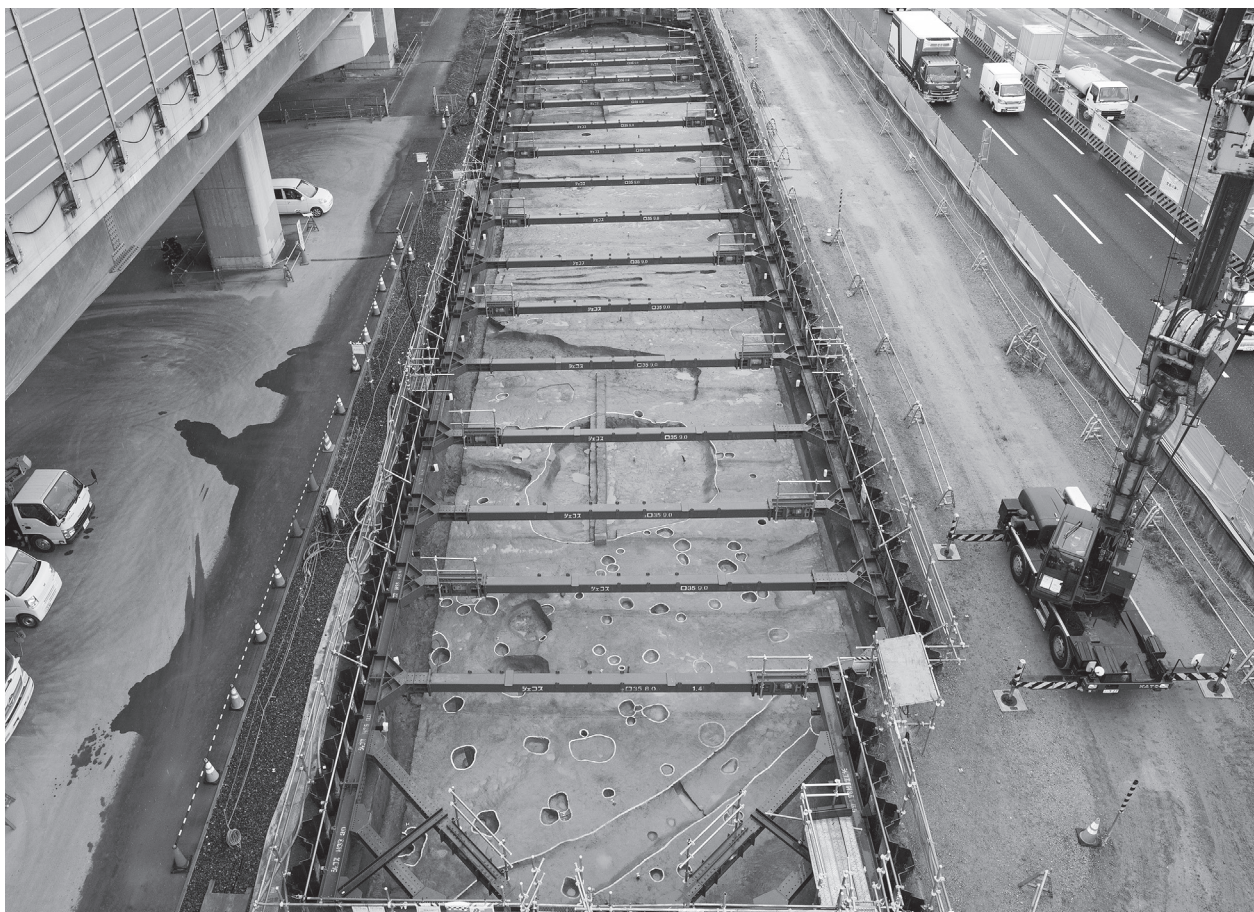
2. 3区 第3面全景 (南から)
