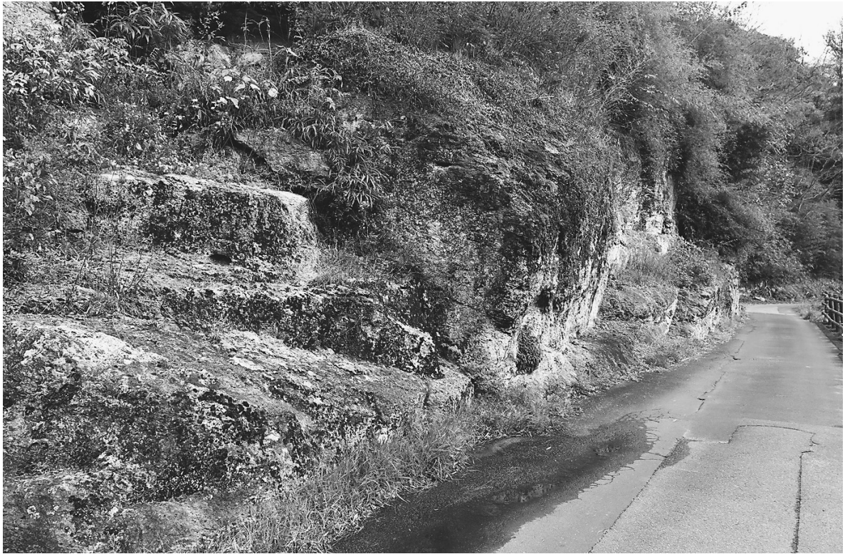
写真4 大森町の観世音寺下の採石跡
