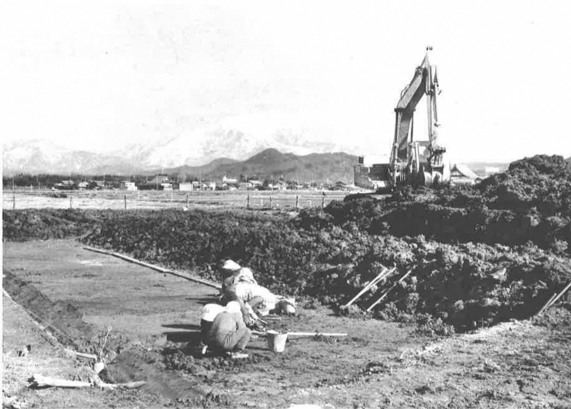
(1) 調査作業風景
