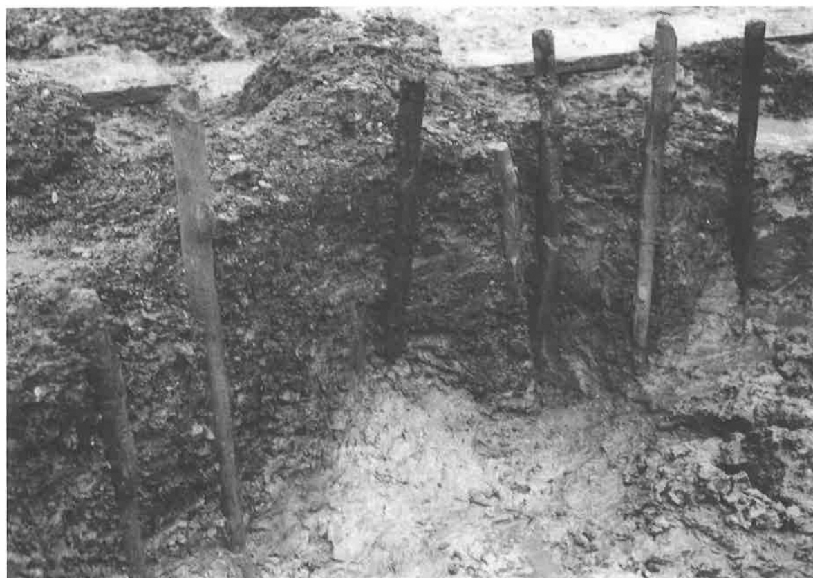
(2) 杭列SX01断ち割り状況
