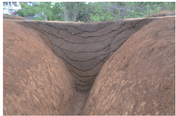
3. SD01 Fセクション (南東から)
