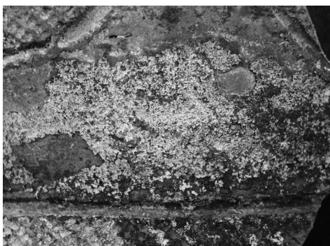
OKOD10 外面試料付着状況
