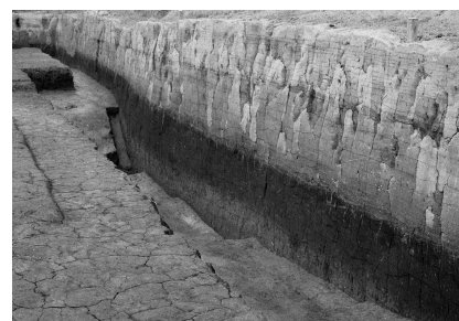
図48 たわみ部の土層
