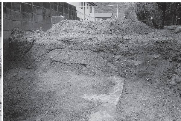
試掘2次Cトレンチ 土層断面（南から）
