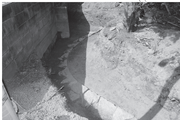
水路のコーナー部分（試掘2次Cトレンチ）（南西から）
