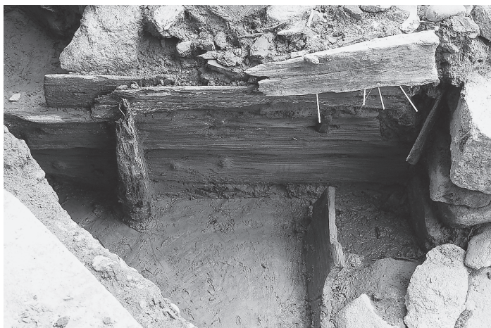
b. 上流側樋門南側護岸 (北から)
