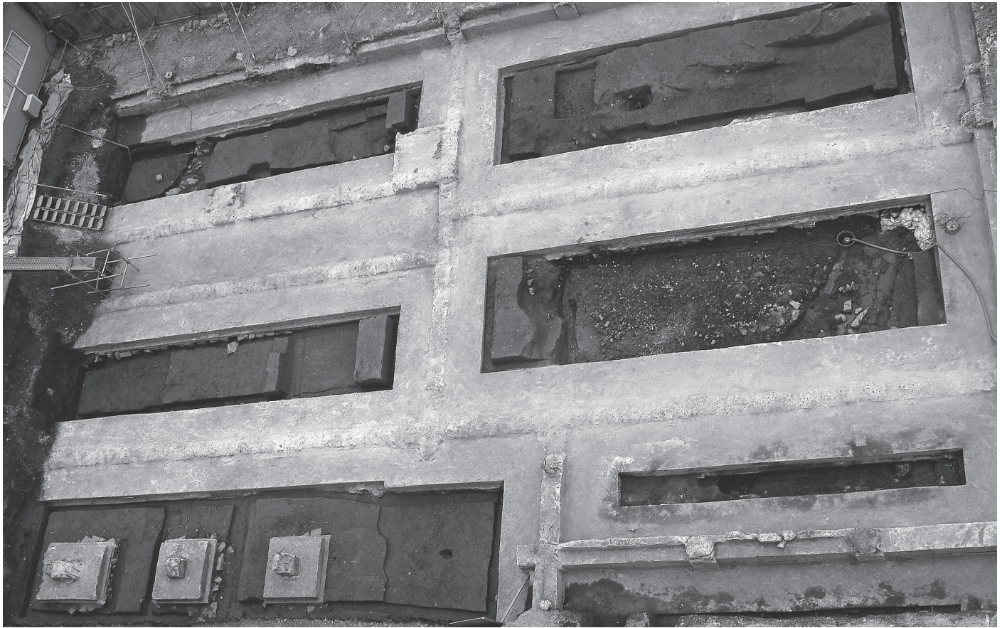
a. 前期調査 (西から)
