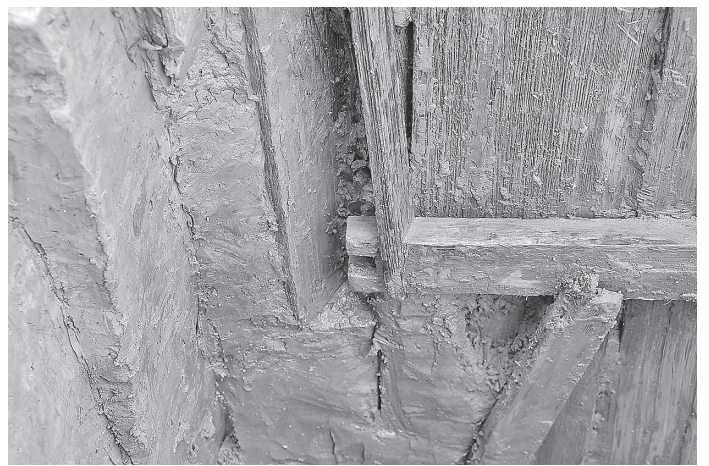
4. 北西角の横木と支木（南から）
