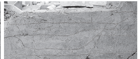
9. 溝10断面 (西から)
