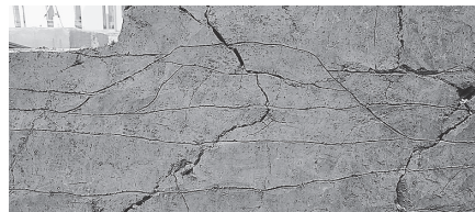
8. 畦畔断面 (西から)
