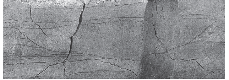
2. 溝23断面 (西から)
