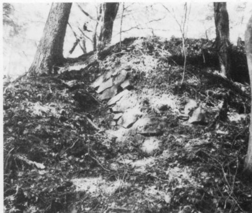
図版19 本丸(上段)南端に露出している石垣
