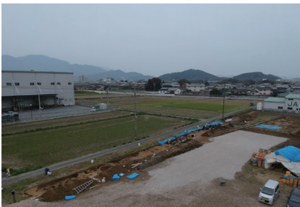
IV区調査風景 (北から)
