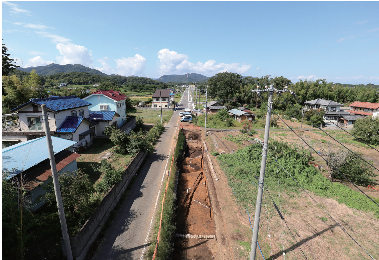
調査区遠景（西半調査時） 東から
