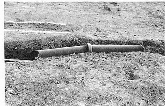
樋4 先端の土管
