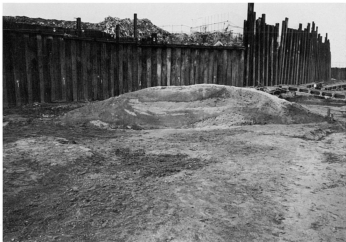
近代石津川右岸堤防断面Ⅰ 8北壁（南より）
