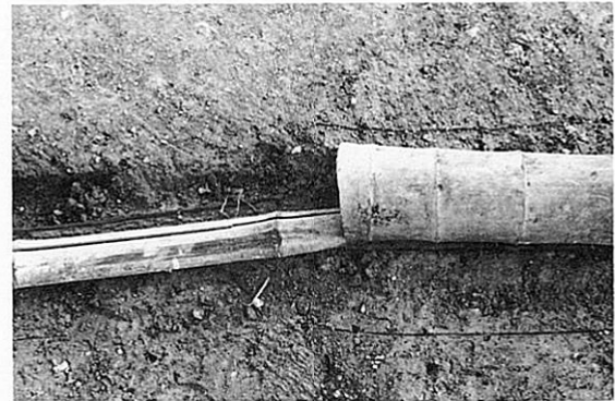
樋4と土管接合部
