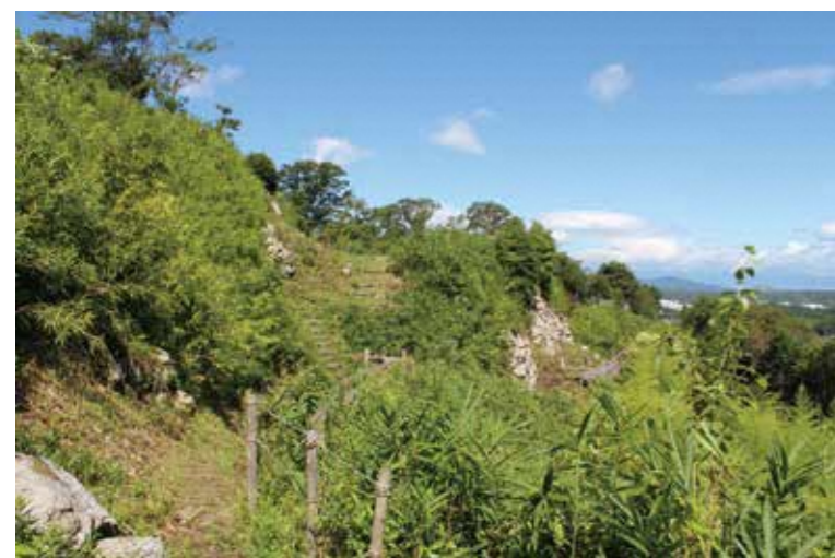
伝本丸北面の2段の石垣
