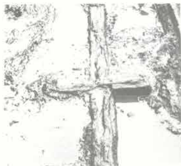
◀3. 同中央部 根太木交差状況 (西から)
