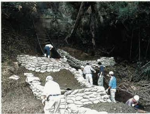
写真162 第13号トレンチ 作業風景
