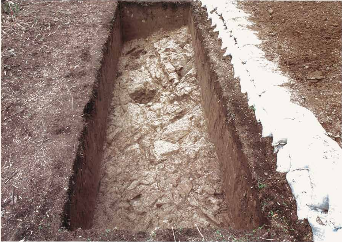
写真79 第33号Cトレンチ 全景(北から)
