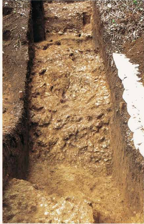
写真18 第7号トレンチ 全景(南から)
