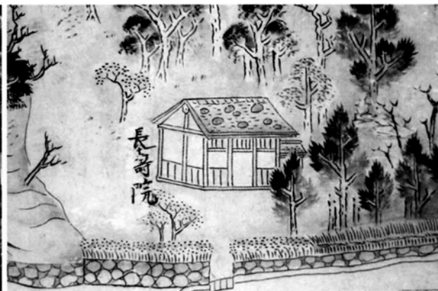
挿図48 17世紀の永平寺塔頭の石置板葺屋根建物 24
