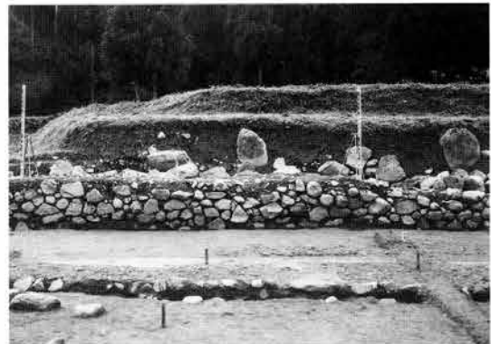
挿図12 土塀基礎石垣SA3184 (東から)
