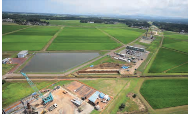
● 調査区全景（市道区、南から）
