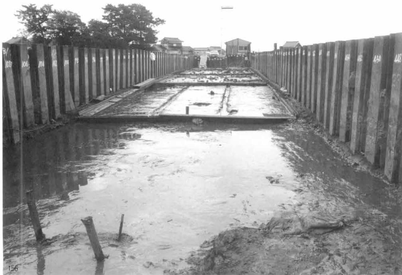
155 W-1-7区 (南より) 156 W-1-5区 (北より)
