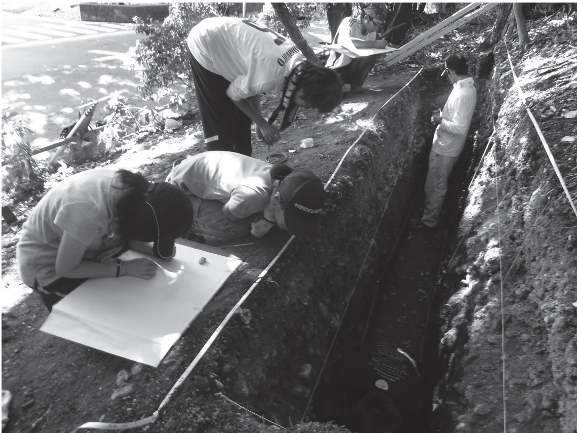
6. 6 トレンチ測量風景
