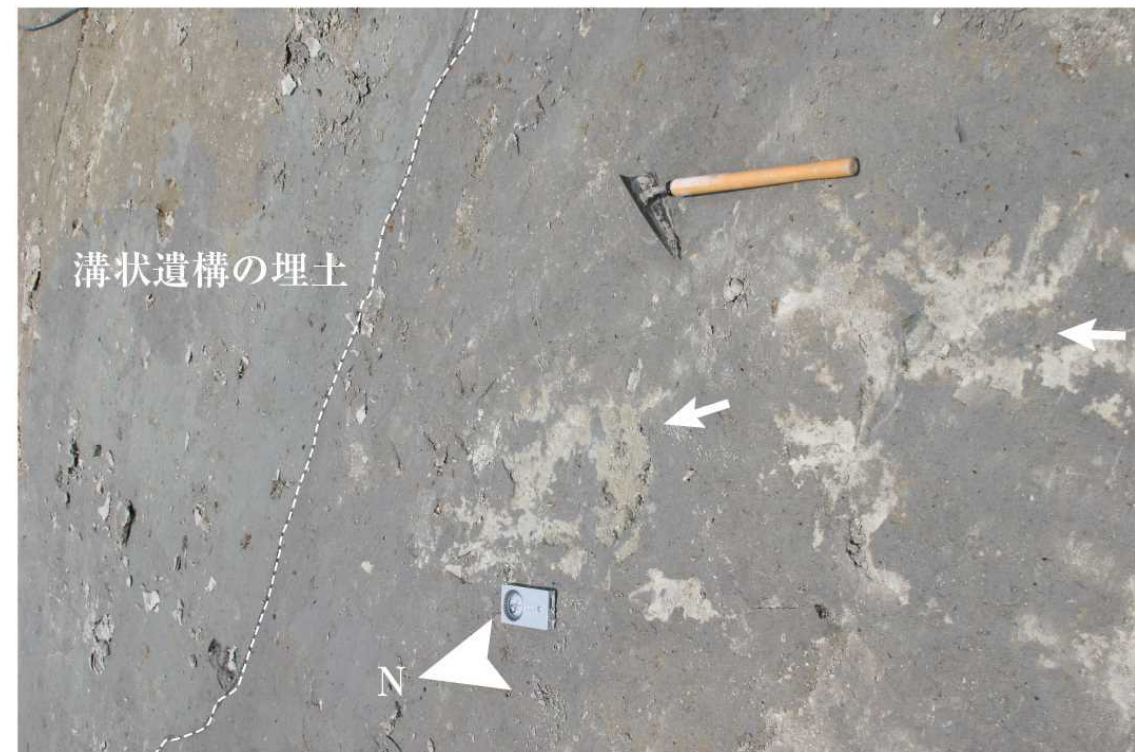
写真4 南北方向に向かう地割れ
