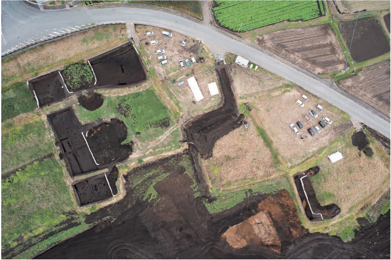
図版3 令和3年度調査区全景（南から）
