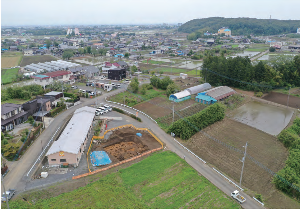
鷺山南遺跡B地点調査区遠景（南西より）
