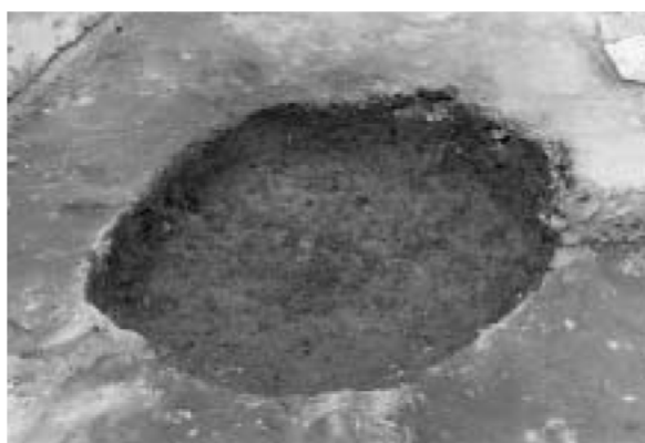
6-B~C区 SK107 (南から)
