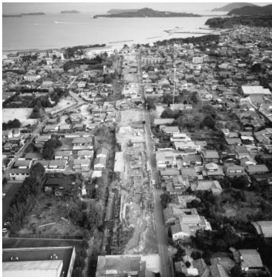
5-1 中区全景 および周辺（南から）
