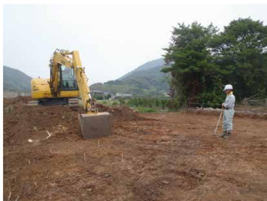
写真1 重機による表土除去
