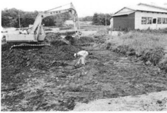
△重機による耕土の除去
