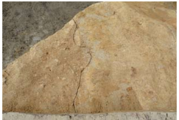
土塁粘土貼り付け状況
