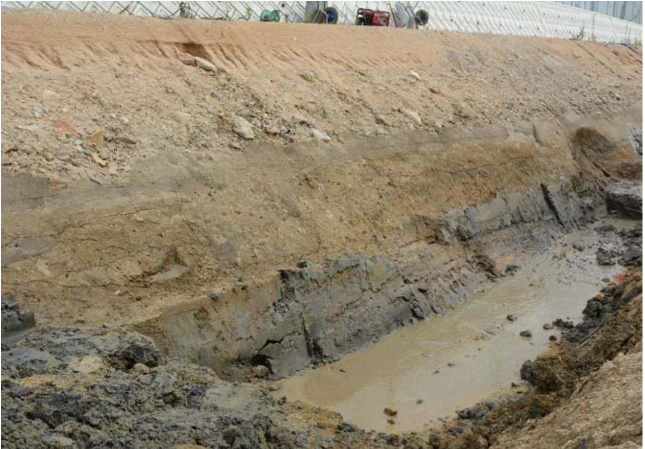
2区堀完掘状況（南西から）
