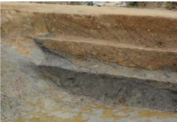
堀土層断面東部分拡大（北西から）
