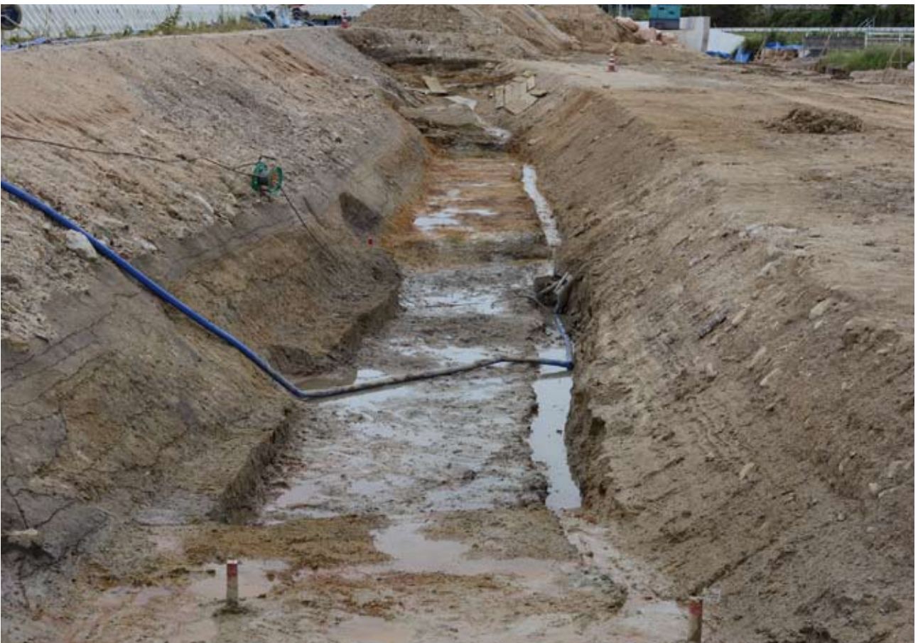
2区完掘状況（西から）
