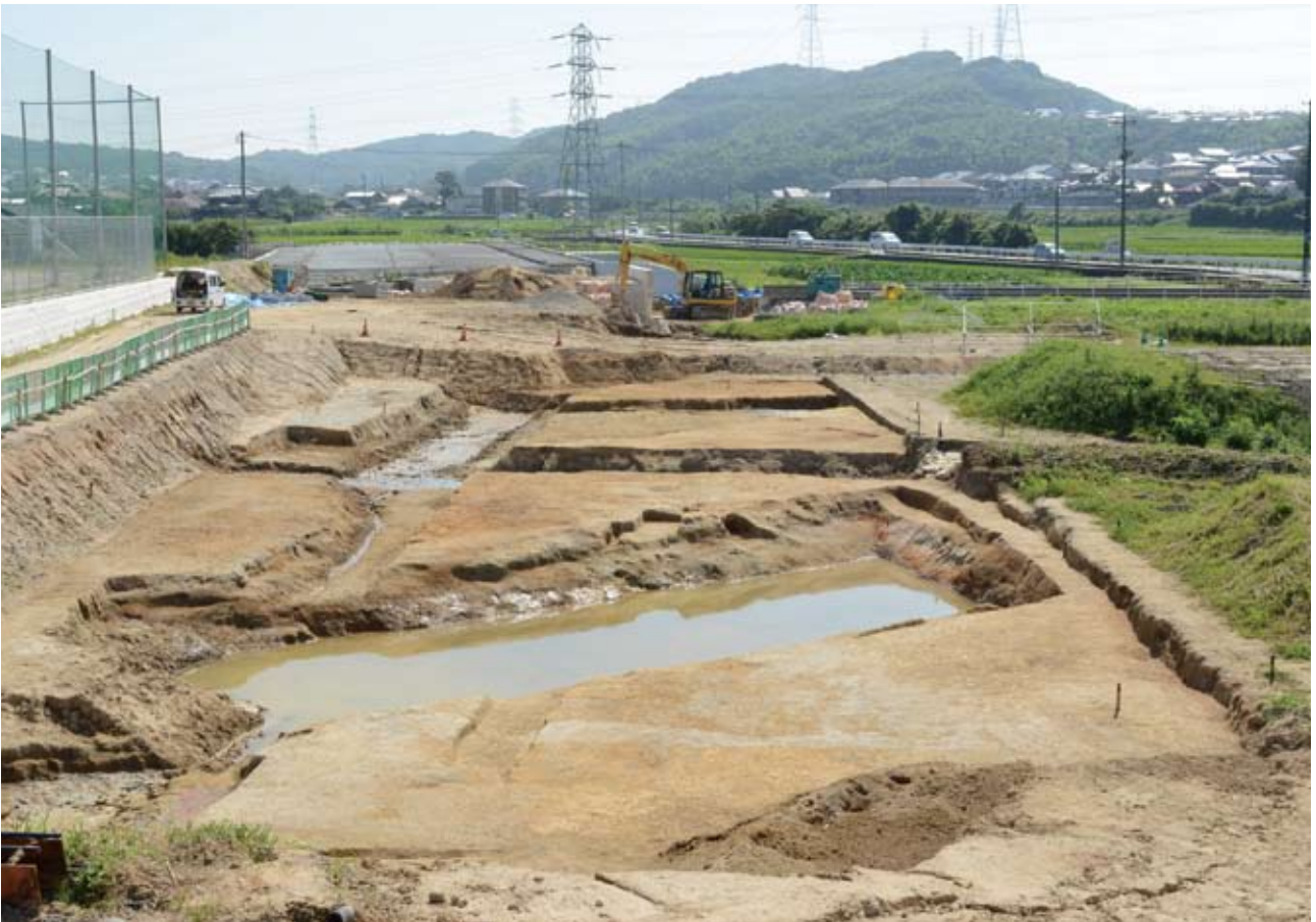
1区近景（西から）
