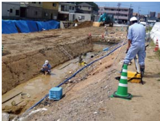
写真3 国土座標杭設置
