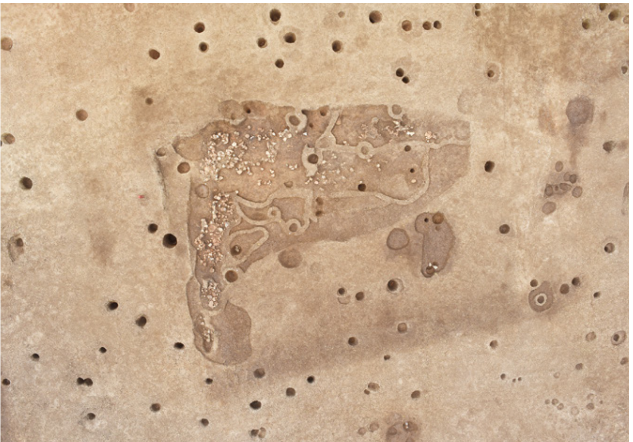
SX01 周辺部（鉛直上空から）
