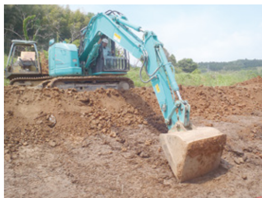
写真1 重機による表土除去
