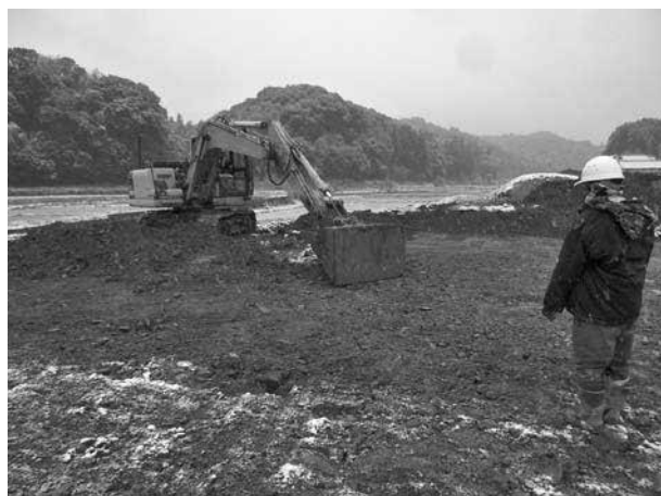
重機による表土除去作業
